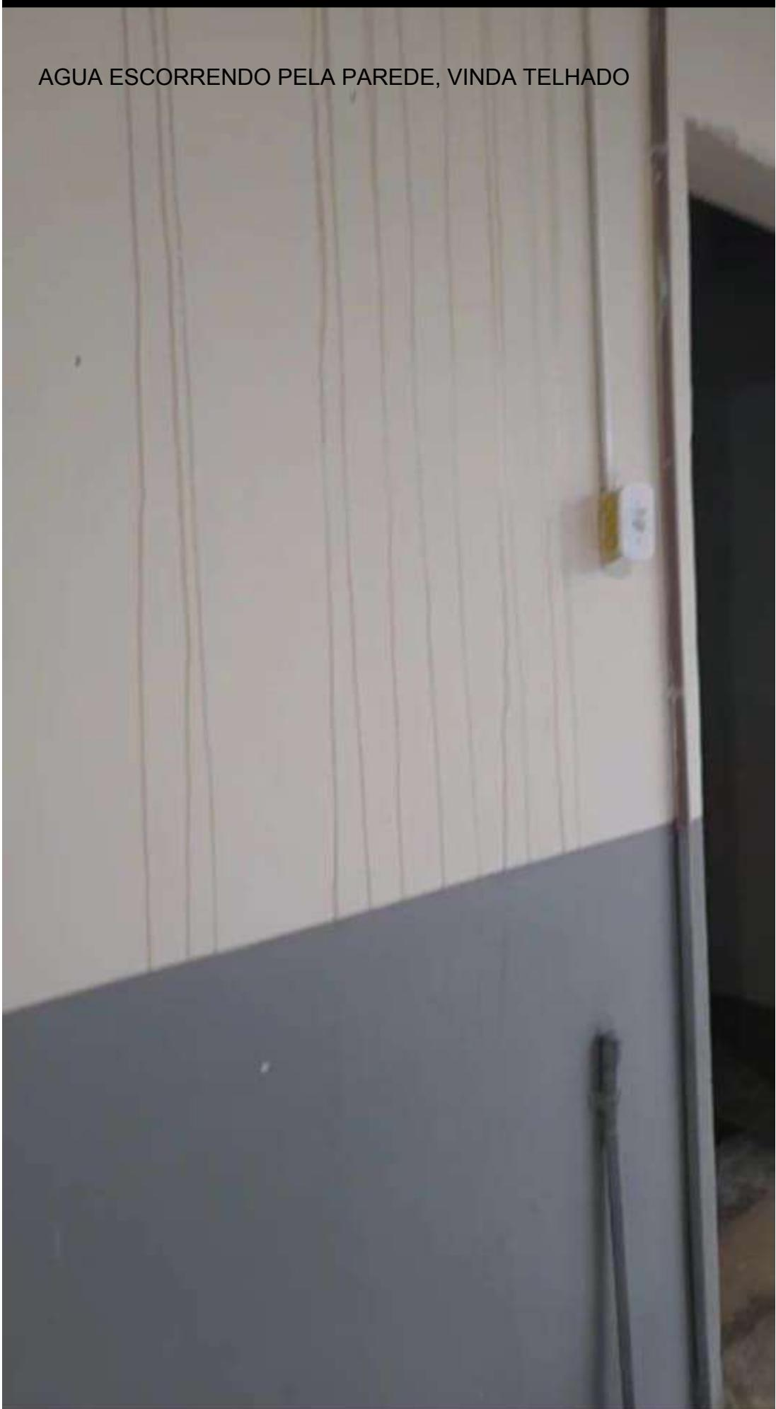
AGUA ESCORRENDO PELA PAREDE, VINDA TELHADO
