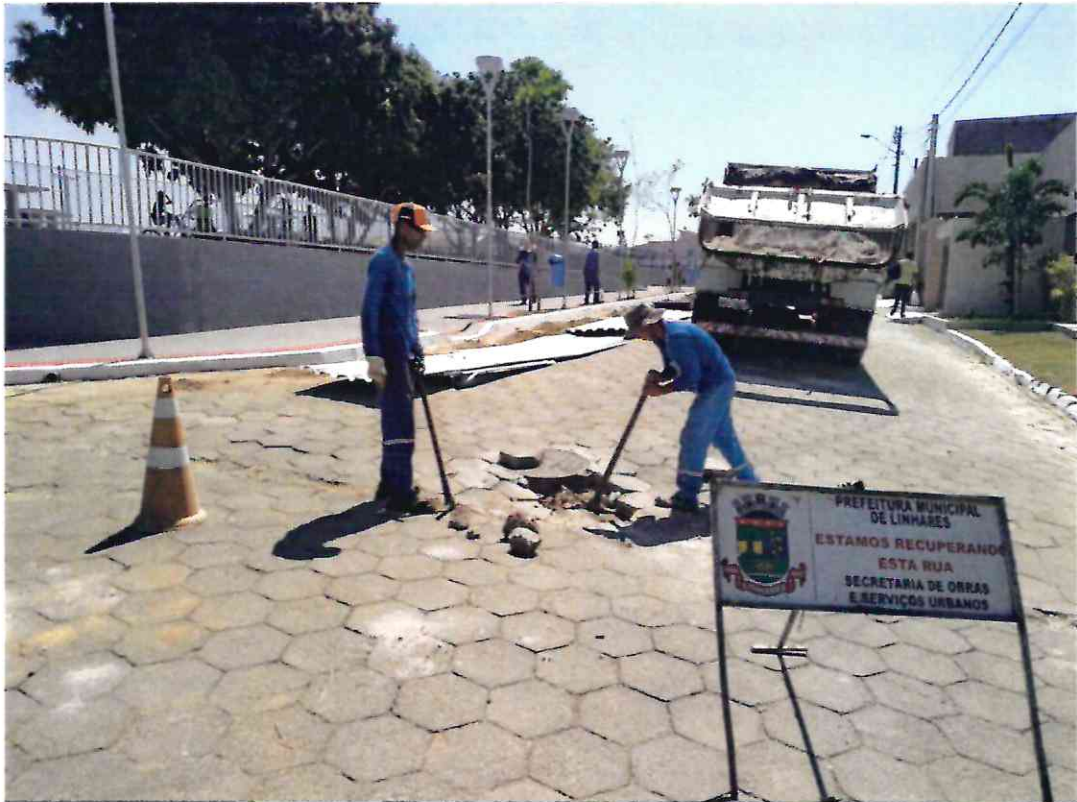
Figura 1.2 - Recuperação da Rua
