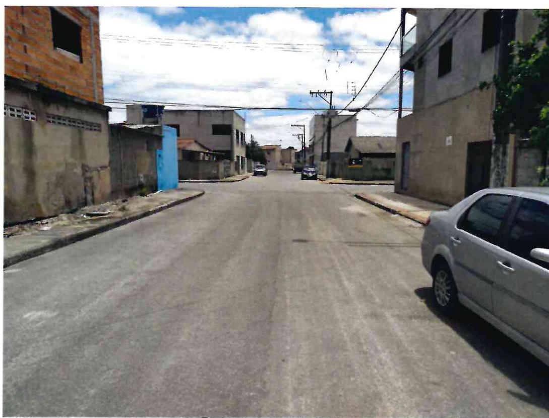
RUA FUNDÃO EM FRENTE A CASA DE Nº 84 E RUA MEM DE SÁ EM FRENTE A CASA DE Nº 128
