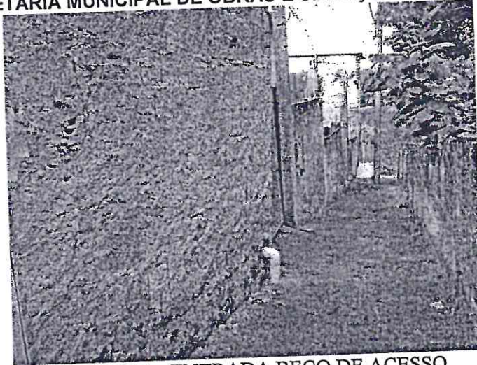
FOTO Nº17 - ENTRADA BECO DE ACESSO
