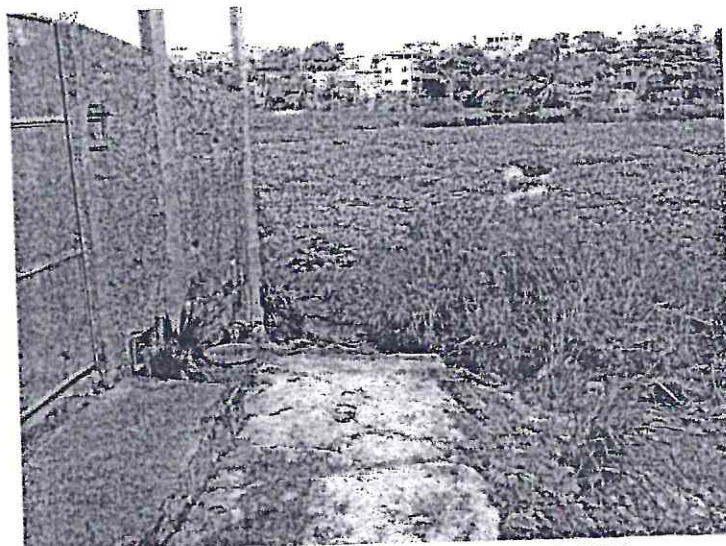
FOTO Nº 19 – FINAL BECO DE ACESSO
