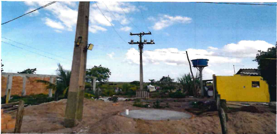
Poste sob nº 8877- Localidade Cacimbas.
