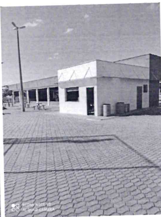
Foto 2: Iluminação acesso cantina
