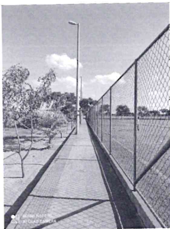
Foto 3: Iluminação calçada redor do campo
