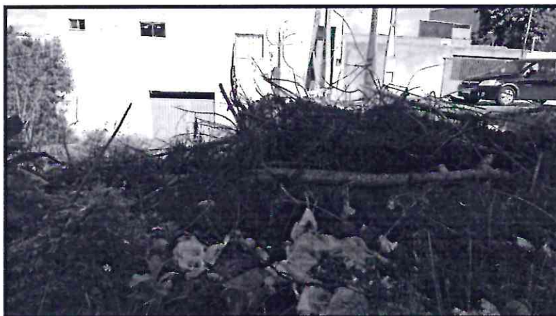
FIGURA 02: LIMPEZA E RETIRADA DE ENTULHO ATRÁS DA JUNAL
