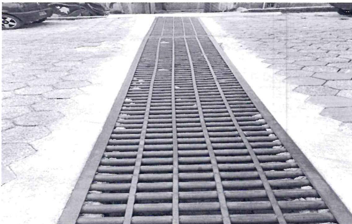
Veja nessa esquina fora instalado esse bueiro, que auxiliou em muito o escoamento, mas que por si só não é eficiente, dessa forma vamos juntar fotos da outra esquina que seria preciso a instalação de um desse.
