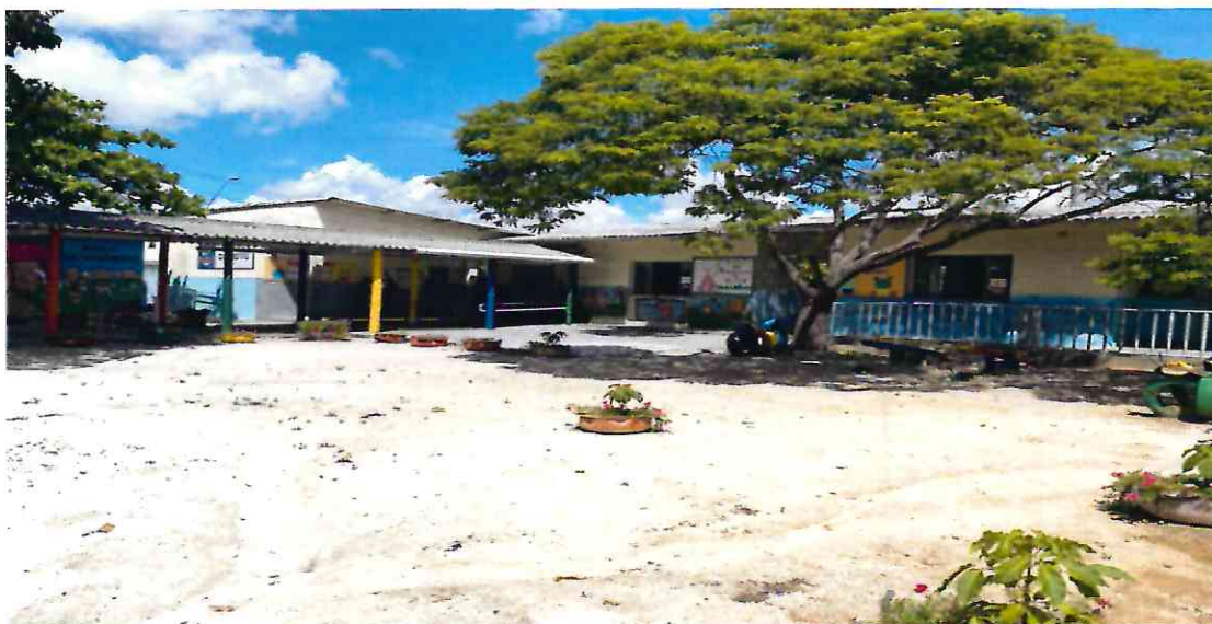
ESPAÇO PARA CONSTRUÇÃO DO AUDITÓRIO
