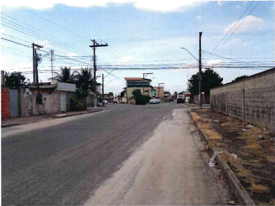
ENTRONCAMENTO DA RUA ARARIBÓIA COM AS AVENIDAS BARÃO DO RIO BRANCO E PRES. EMÍLIO GARRASTAZU MÉDICE.
