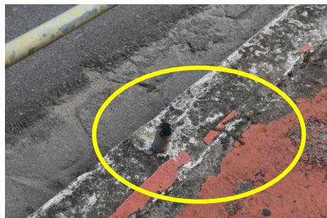
**Em um dos pontos da passarela, há risco de desmoronamento de parte da calçada lateral, conforme a imagens abaixo:**
