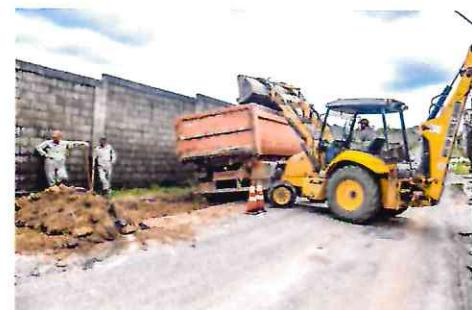
As intervenções, necessárias para o escoamento da água da chuva, acontecerão numa extensão de 560 metros, nos dois sentidos da via. Posteriormente à obra, o Serviço Autônomo de Água e Esgoto (SAAE) de Linhares vai reestruturar a antiga rede de distribuição de água, com a substituição da tubulação existente. Para essa obra, não será necessária a interrupção do abastecimento.
