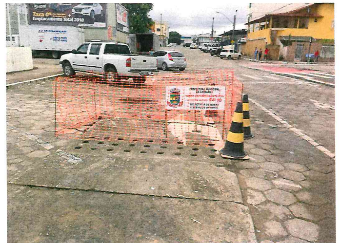
Troca e manutenção na tampa da Galeria.
