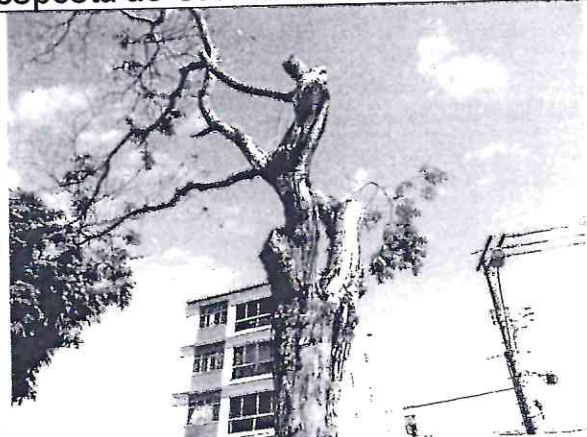
Figura 4 – Destaque para podas feitas anteriormente, com reprovação técnica total, pontas de galhos que se tornam ponto de entrada de brocas e cupins.
